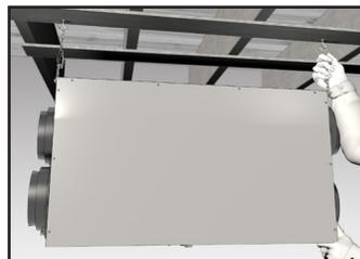
**3** Suspendez le VRC en faisant glisser un maillon de la chaîne dans les crochets de suspension et assurez vous que l'appareil est de niveau.
