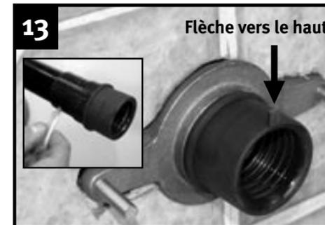
**13** Lubrifier soigneusement l'extérieur du manchon de caoutchouc et l'intérieur de la surface cannelée. Insérer le tube et le manchon en plaçant la flèche vers le haut. Lubrifier le renvoi du boîtier.
