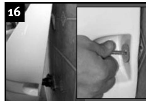
**16** Accrocher la cuvette en insérant le tuyau de renvoi dans le manchon. Monter les vis du bas de la cuvette et leurs rondelles. Serrer les noix de la bride et la vis de la bande de serrage.
