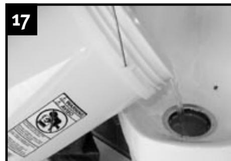
**17** Verser rapidement dans le boîtier 5 gallons (18 litres) d'eau pour vérifier l'écoulement, l'étanchéité et s'assurer qu'il ne reste aucun liquide au fond du boîtier.
