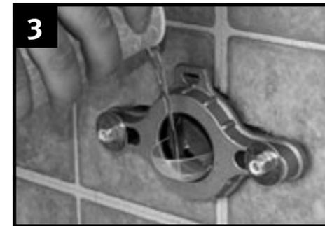
**3** Nettoyer la surface de la bride existante et y monter la bride de laiton fournie, munie du capuchon d'inspection transparent. Verser lentement de l'eau dans le renvoi.
