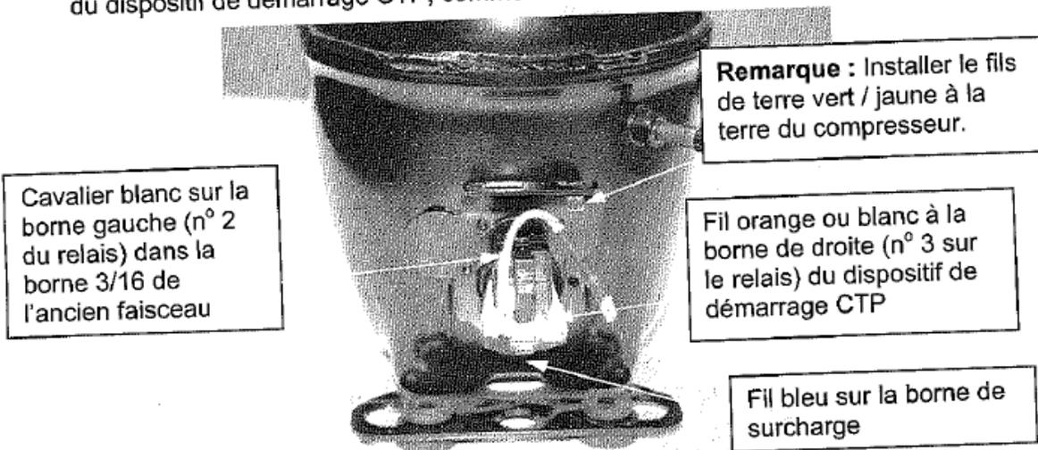
8. Réinstaller le faisceau de fils aux bornes qui conviennent.
